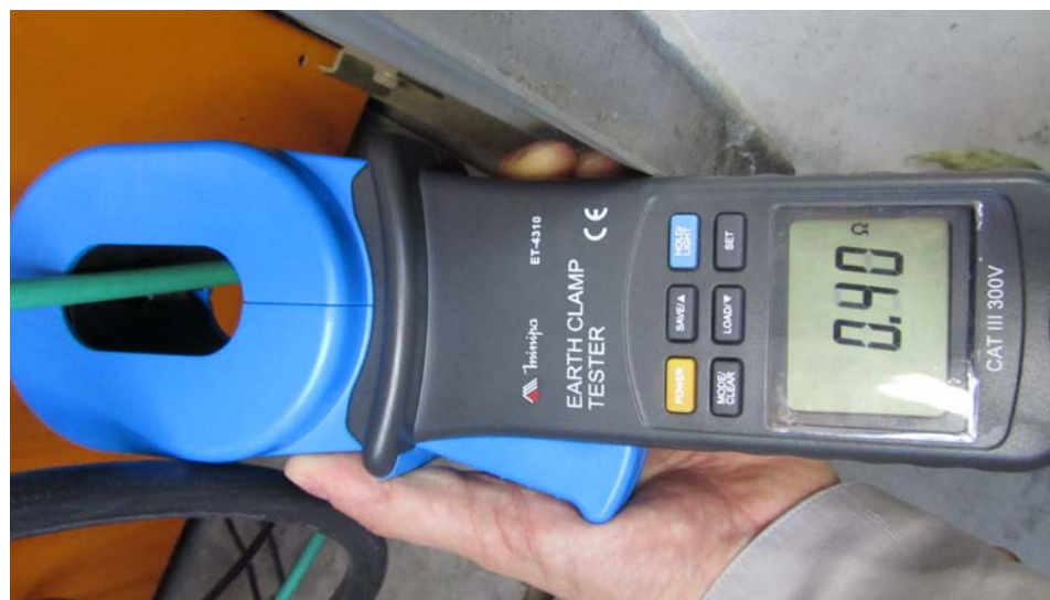
Figura 2: Valor de aterramento medido em um ponto da Fábrica 1
